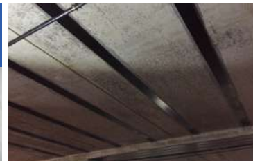
INSTALACIÓN FIBRA DE CARBONO ESTRUCTURAL
