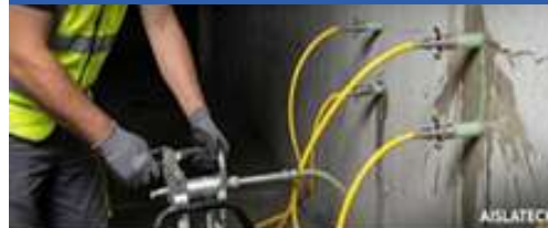
ESTACIONAMIENTOS SUBTERRÁNEOS: INYECCIÓN DE FISURAS & RESINAS
